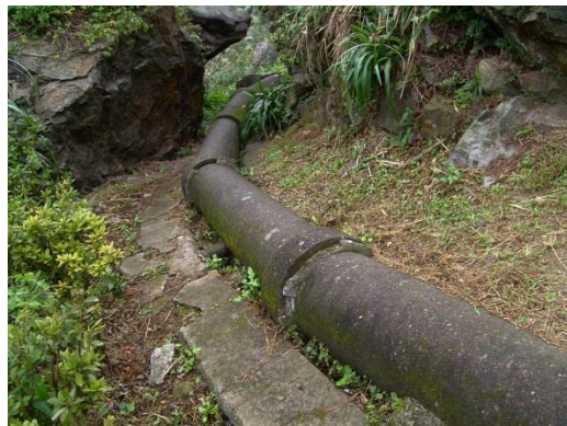
引水道所用的水泥水管
