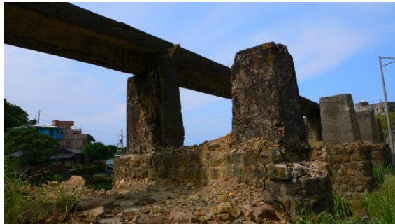
架高的水圳橋
